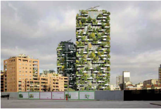
Nanjing Greens Towers (Trung Quốc)
